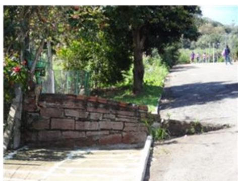
- Contenções na calçada e leito da via
