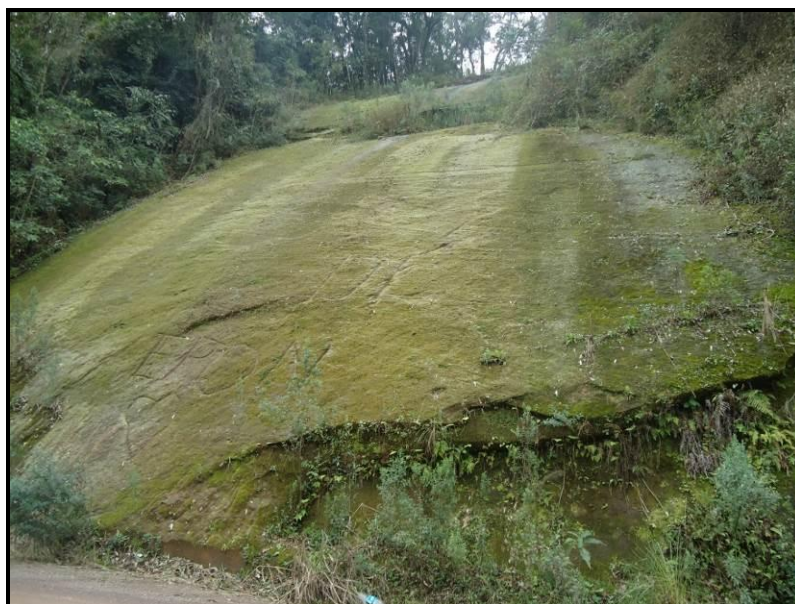
Figura 30. Deslizamento em encosta (Ponto 20).
