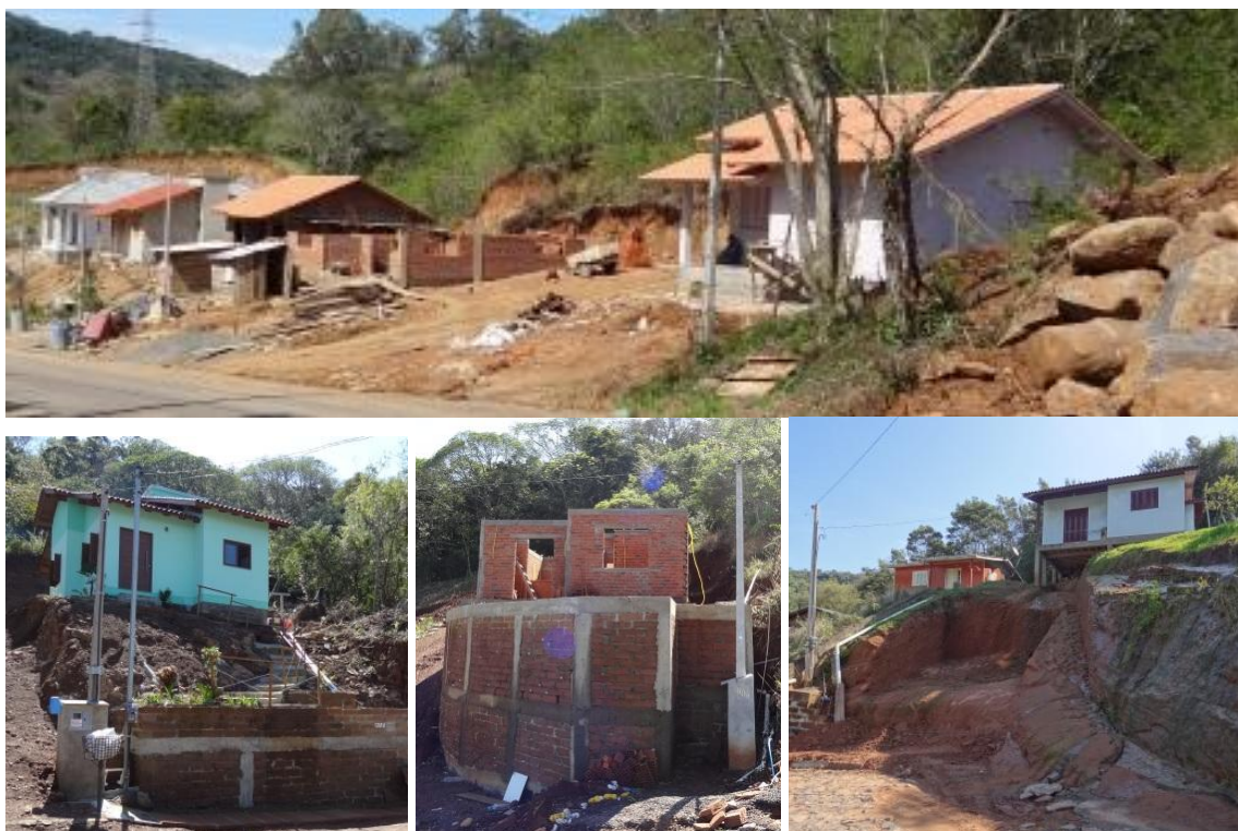
Figura 19: Novas construções em terrenos com topografia acidentada. Fonte: GRID/UFRGS.
