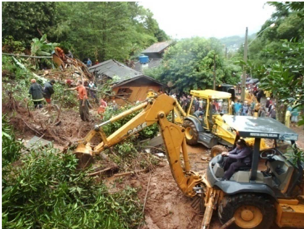
Figura 8 – Escorregamento de 23-04-2011 com 7 vítimas fatais.
